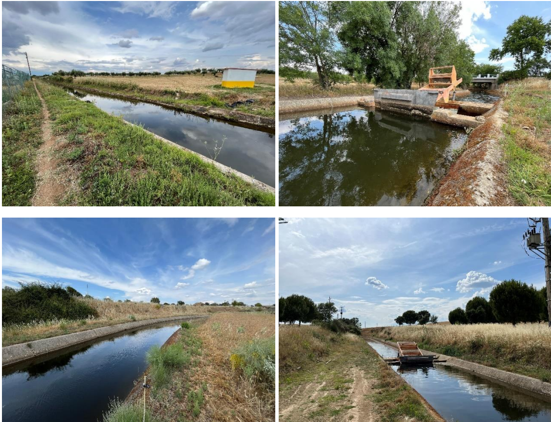
Figura 11.2 - Aspeto geral do CCG
